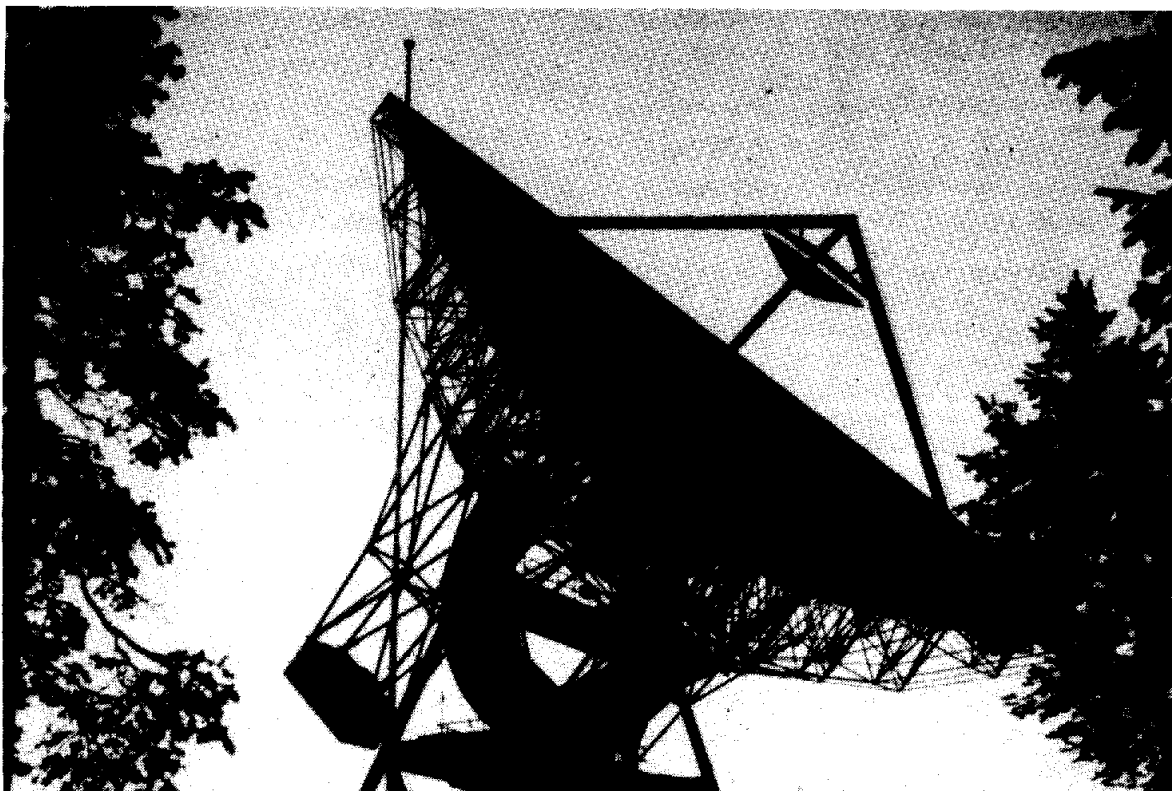
Bild 1: Der 32-m-Parabolspiegel mit Cassegrain-Erreger bei der EISCAT Empfangsstation in Sodankylä, Finnland. Baugleiche Systeme befinden sich in Tromsø, Norwegen, und Kiruna, Schweden. Auf den Meßfrequenzen bei 931 MHz steht ein Antennengewinn von 48 dB zur Verfügung, die Halbwertsbreite der Hauptkeule beträgt 0.6°. Foto: DF5AI
